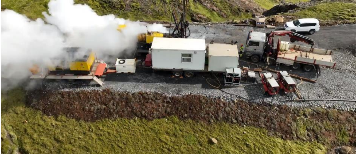
MYND 4.2 Hér sést vel hvernig búið er að setja mosalag í kanta borplansins til að endurheimta eins mikið af raski og hægt er.
