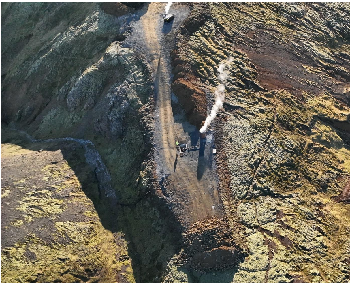
MYND 4.5 Holur 2 og 3, stærð framkvæmasvæðis haldið í lágmarki og lítið sem ekkert rask fyrir utan.
