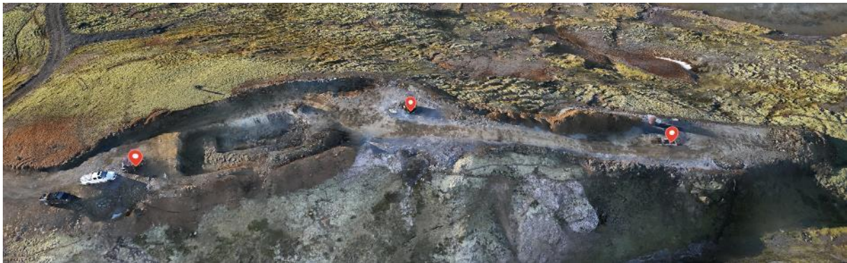
MYND 4.1 Framkvæmdasvæði borhola 1-3. Lítið sem ekkert rask út fyrir framkvæmdasvæði. Myndin er tekin á framkvæmdatíma áður en frágangi er lokið.
