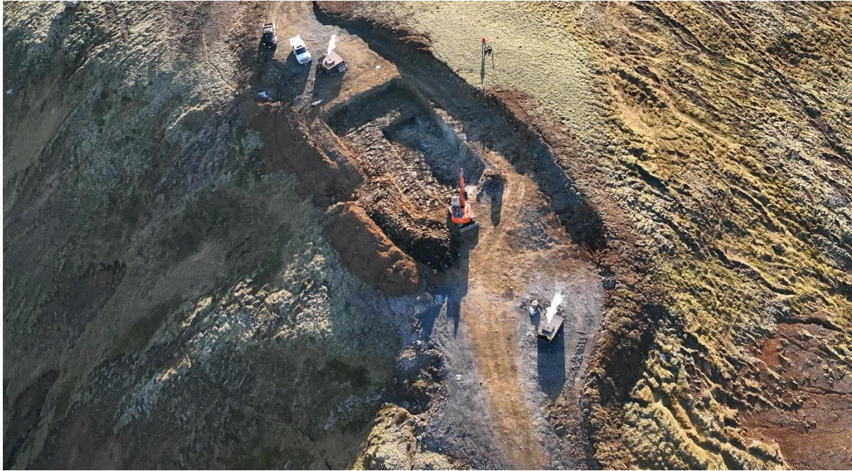
MYND 4.4 Holur 1 og 2 og grunnur aflstöðvar, stærð framkvæmasvæðis haldið í lágmarki og lítið sem ekkert rask fyrir utan.
